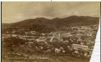
Panorámica de la zona de Maestranza en Real del Monte
